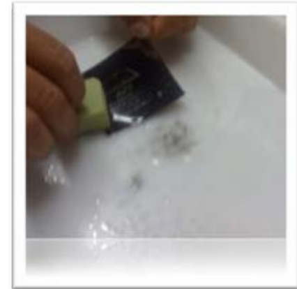
Paso 9: Retire el excedente con una esponja
